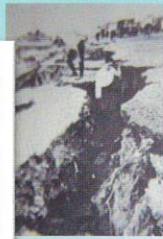
県庁前の地割れ
